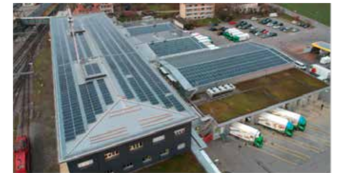
Installation PV de Kellenberger (env. 2800 m 2 )
